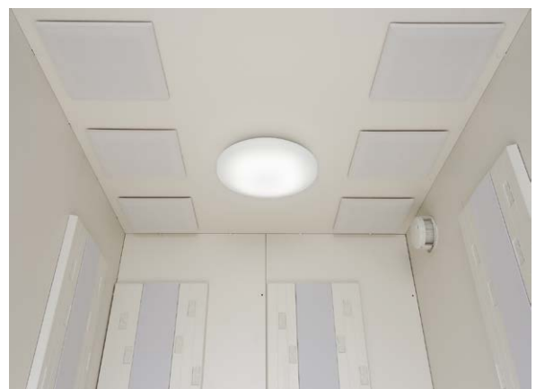
■音場天井パネル/照明器具
